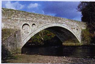
Pont de pierre – Arc et tablier en pierre
