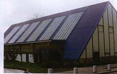
Gymnase – Façade en tôles métalliques – Toiture en tôles métalliques et plaques de matière plastique translucide
