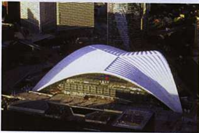
CNIT Paris la Défense – Voile en béton armé – Façades en verre
