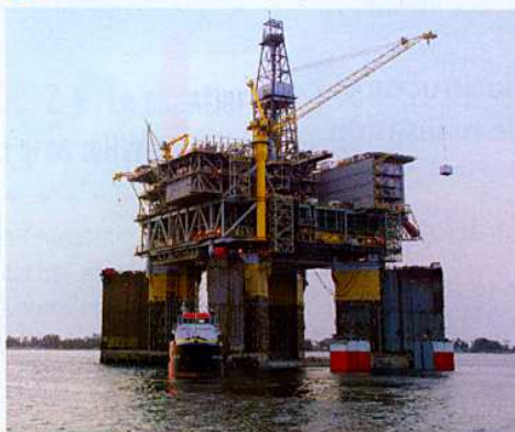
a Plateforme de forage pétrolier en mer
