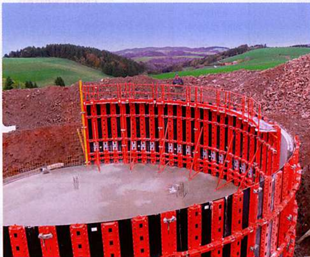
a Le coffrage d'un ouvrage cylindrique
