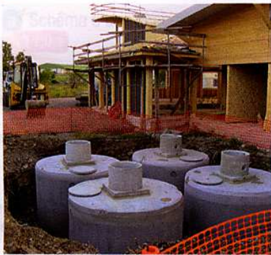
a L'installation de cuves en béton
